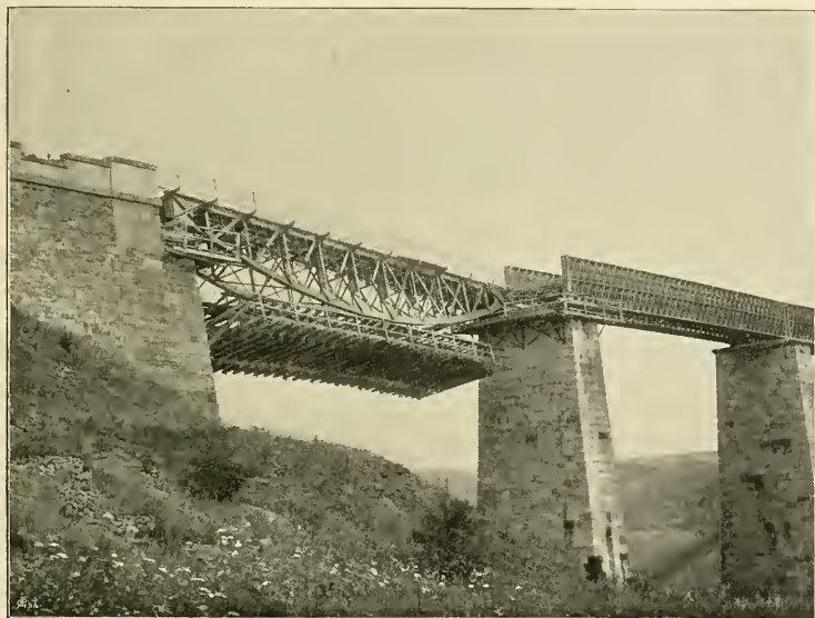
Abb. 144. Schifkornbrücke. [Klabawa-Viaduct bei Chrast während der Auswechslung 1892.] [Nach einer photographischen Aufnahme von F. Dwořák in Pilsen.]
